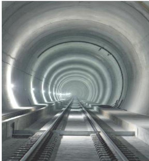
Fig. -8. Tunnel de Lötschberg (Suisse) réalisé par un béton à fumée de silice
