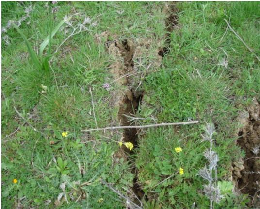
**Figure II. 4 : Fissures au niveau du talus**
