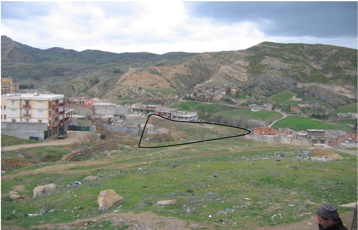
Figure 3.1 : Vue d'ensemble du glissement de Beni Khellif
