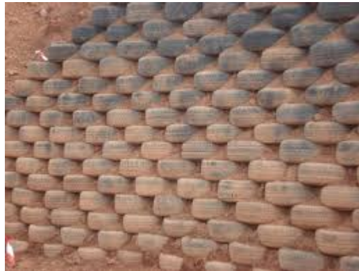
Figure 1.13 : Ouvrage en Pneusol
