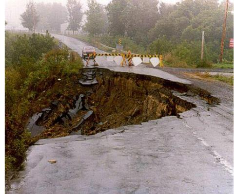
**Figure 6 - glissement rotationnel
