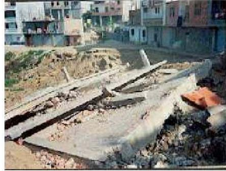
**Figure 7 : Glissement Smina (BEDJAIA): Vue sur l'escarpement et sur les 3 dalles d'une habitation**
