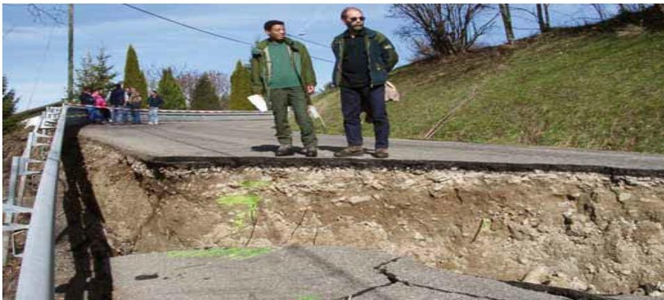
Figure 1 Effondrement d'une route suite à un mouvement de terrain
