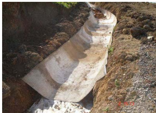
Figure I.15 : Collecte et canalisation des eaux de surface
