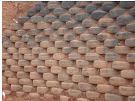
Figure -I-13 : Ouvrage en Pneusol
