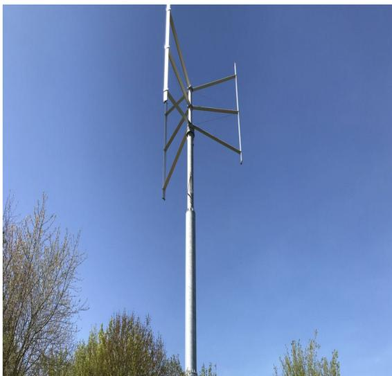
**Figure II.2 : les mâts tubulaires supportant des VAW.**
