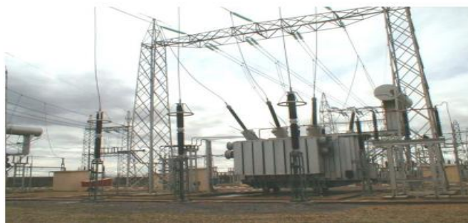
Figure.I.12. Photo d'un parafoudre.[7]
