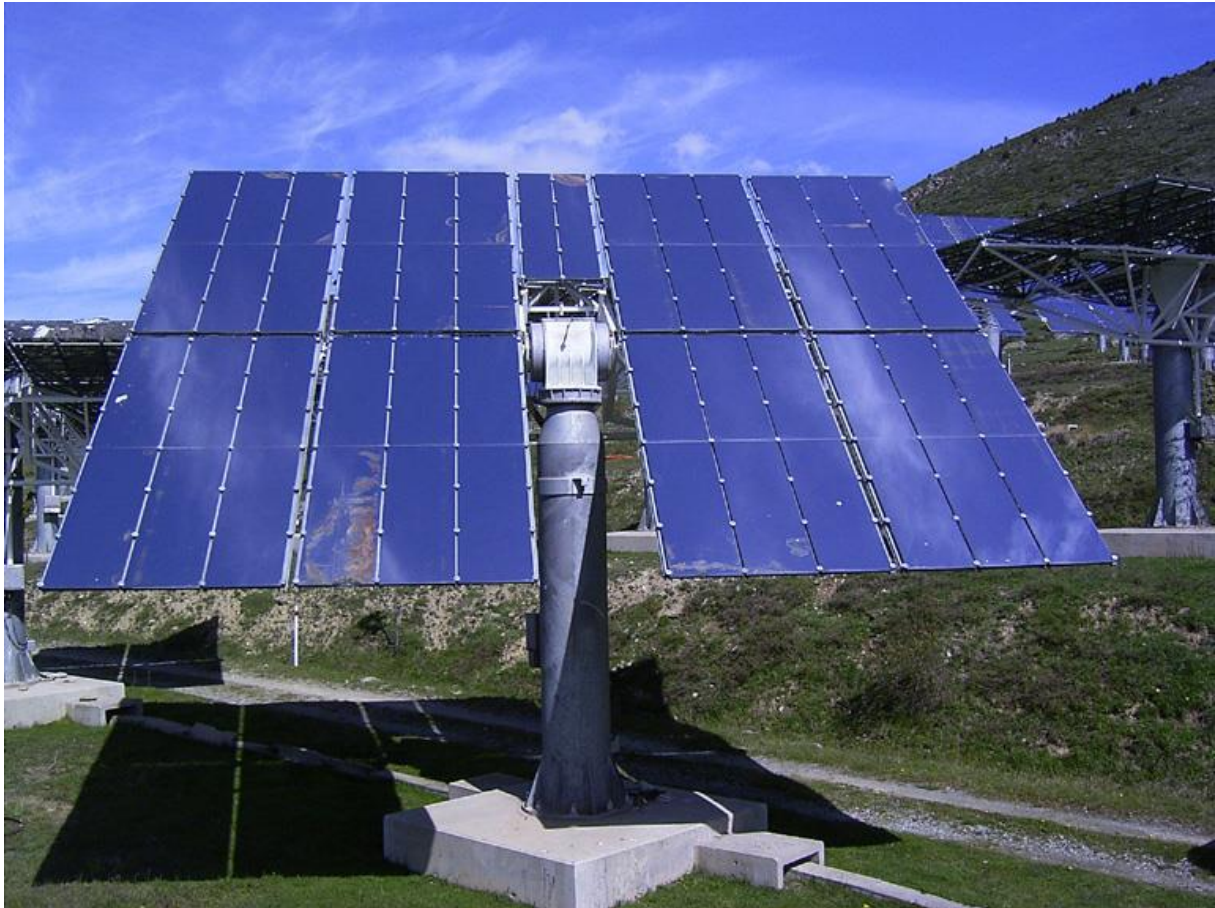
Figure I.4 : Un héliostat de la centrale solaire Thémis.
