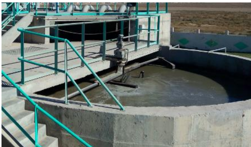
Figure IV.5 : Bassin dessablage /déshuilage (Prise par l'auteur)
