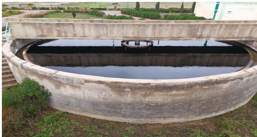
Figure IV.12 : Épaississeur des boues (Prise par l'auteur)
