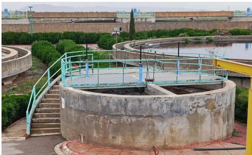
Figure IV.9 : Répartiteur N3 (Prise par l'auteur)
