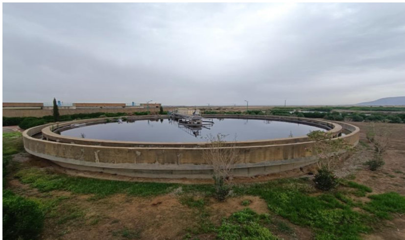
Figure IV.10 : Clarificateur (Prise par l'auteur)
