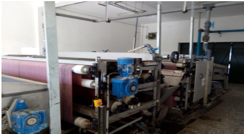
Figure IV.14 : Filtre à bande de déshydratation (Prise par l'auteur)
