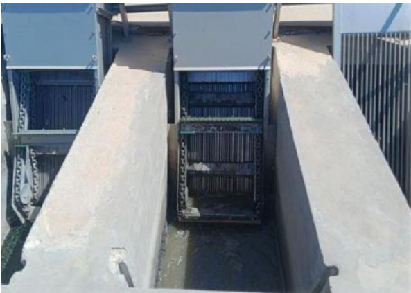
Figure IV.2 : Dégrilleurs fine (Prise par l'auteur)
