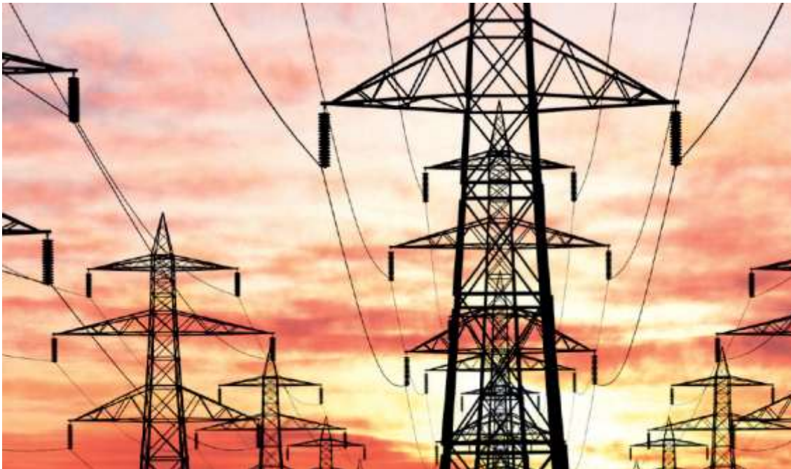
Figure II. 1. Isolateurs composites dans les lignes transmission.
