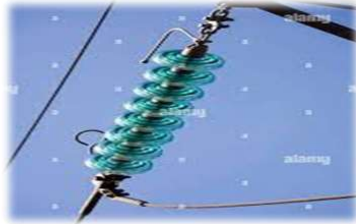
Figure II.2. Isolateur en verre
