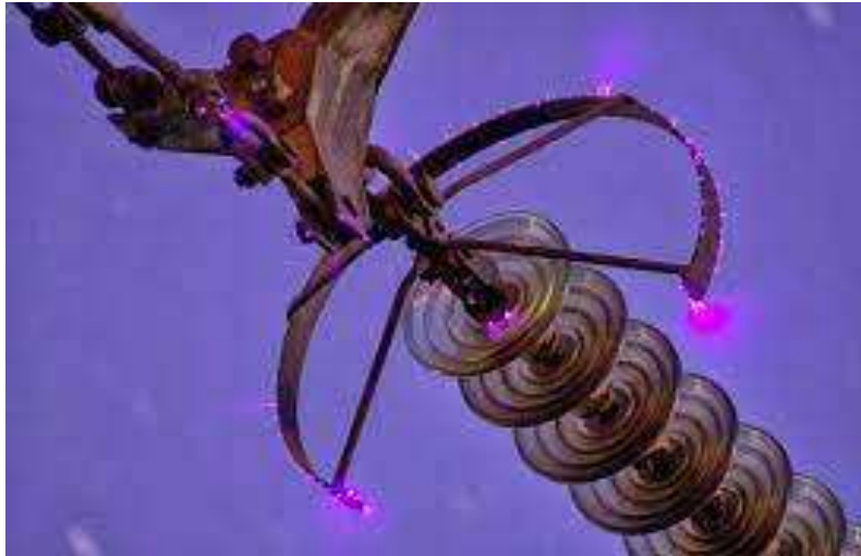
Figure II. 7. Illustration d'une décharge couronne
