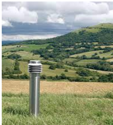
Figure.2.9. La prise d'entrée de l'air neuf .[1]
