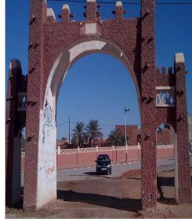
الصورة رقم (21): مواد بناء حديثة للسور المصدر: تعنة، 2015.
