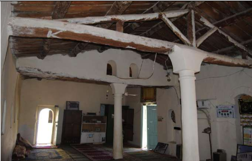
الصورة رقم (10): نظام رفع السقف والأعمدة الأسطوانية للجامع.
