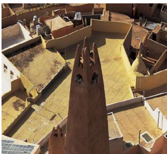
الصور 6: مأذنتي وسطح المسجد العتيق بقصر غرداية.
