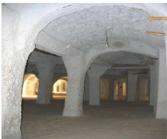
الصور 4: سقف نصف برميلي ودعامات المسجد العتيق بغرداية.
