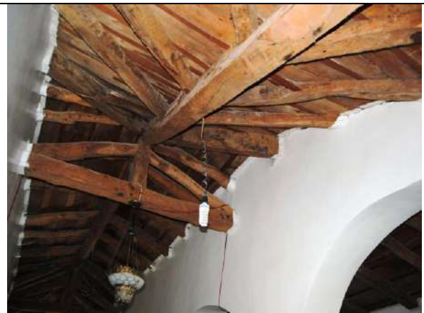
الصورة رقم (24): نظام رفع السقف بالجامع.
