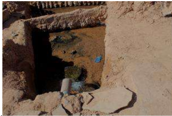
الصورة:13: توضح اختلاط مياه الصرف الصحي بمياه الفقارة في واحة تميمون.
