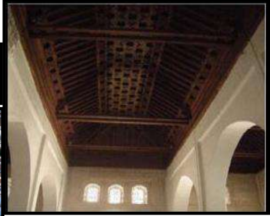
( صورة رقم : 13 ) نظام التغطية "جامع قرطبة"
