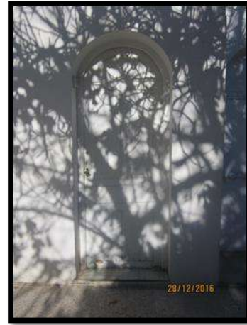
الصورة 16: مدخل مقصورة الإمام بجامع عين البيضاء.
