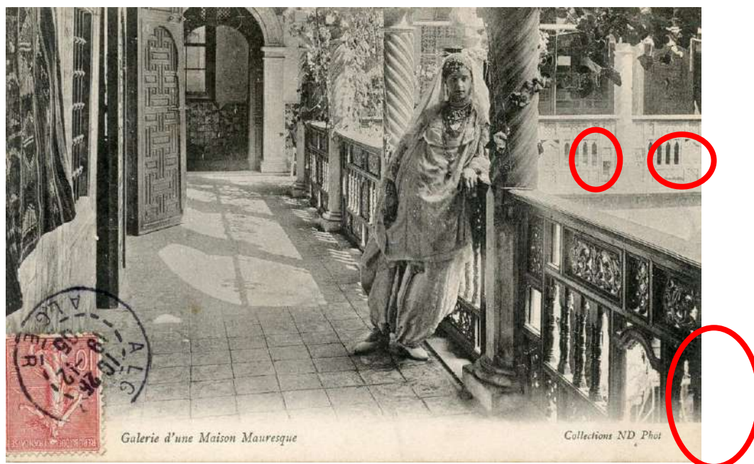
الصورة رقم 08: صورة توضح الفراغ الموجود بالحشوة المركزية للوحدة (ب4).
