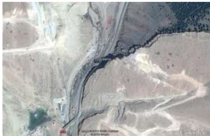
Fig. 1. Localisation géographique du barrage Soubella.
