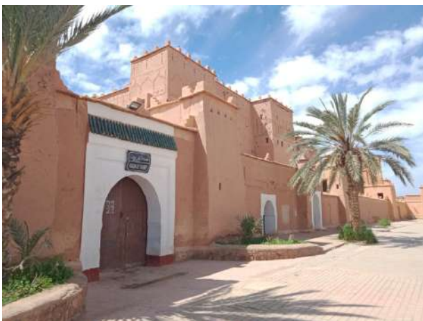
Kasbah de Taourirt, photo prise le 03/04/2021
