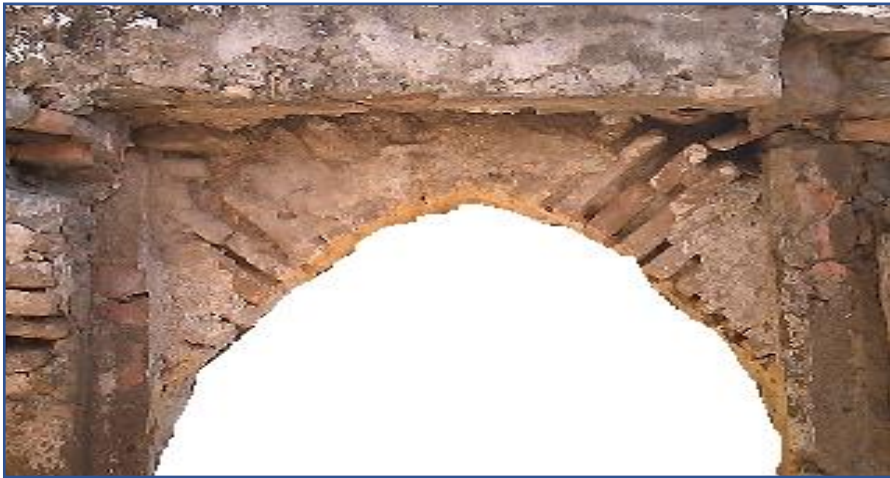
الصورة رقم (1): تقنية بناء العقد بمسجد سيدي بلعباس
