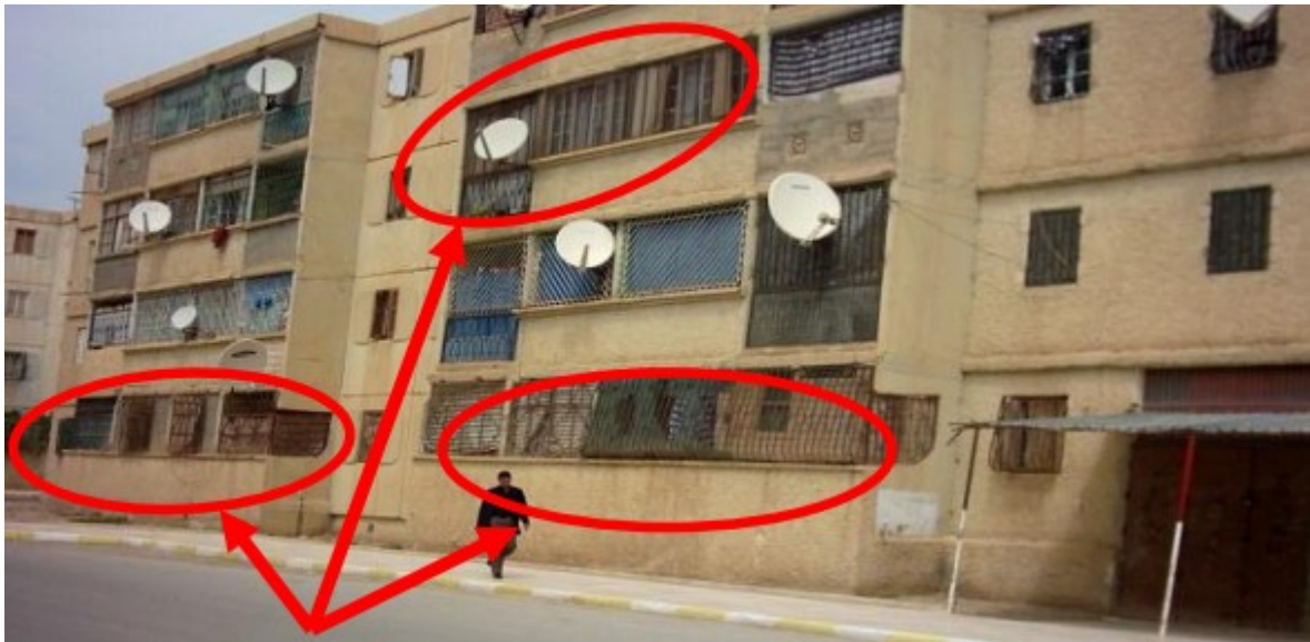
Fig.8 : Les modifications sur la conception interne et les façades des logements.
