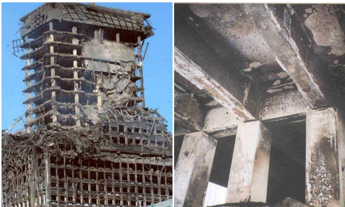
Figure 18 : À gauche, photo du bâtiment Windsor à Madrid après l'incendie. À droite, dessous du tablier du pont à Bruxelles après l'incendie [35] [37].
