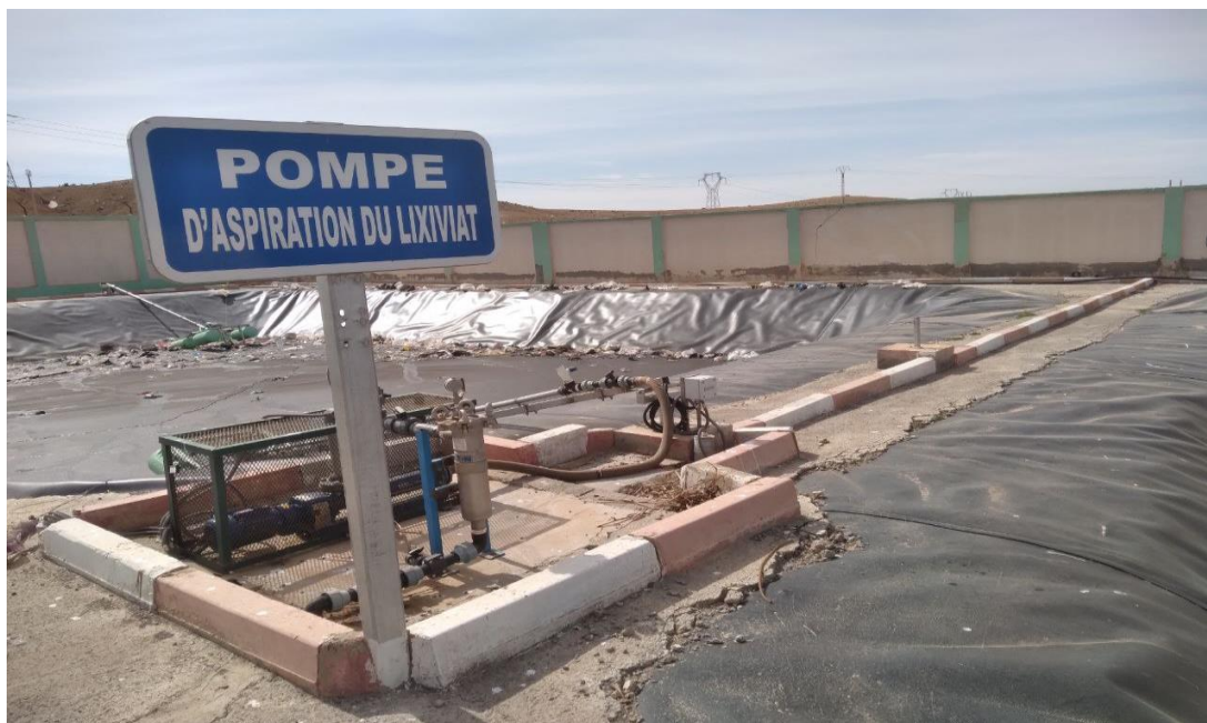
Figure 2.12 : pompe d'aspiration du lixiviats
