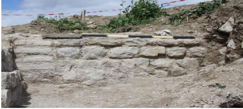
بقايا بنايات لجدران حمامات زدير بئر قاصد علي
