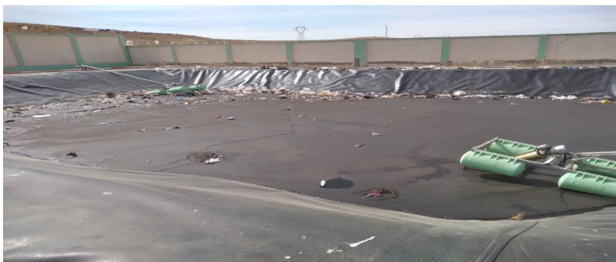
Figure 2.15 : Bassin d'homogénéisation
