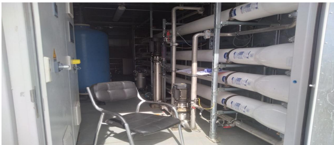
Figure 2.14 : Station de traitement des lixiviats
