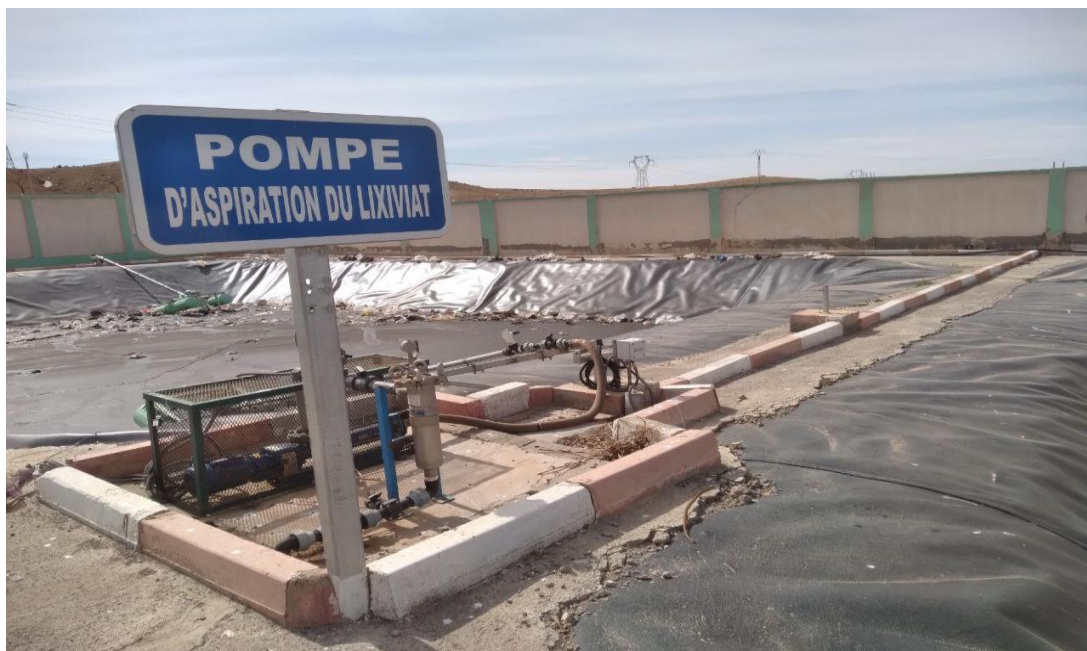
Figure 2.12 : pompe d'aspiration du lixiviats
